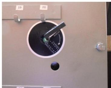
4. Drehen Sie nun den Umstellschlüssel eine Vierteldrehung **im Uhrzeigersinn** bis zum Anschlag und lassen Sie den Schlüssel in dieser Stellung.
