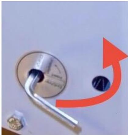
6. Überprüfen Sie zur Sicherheit nochmals, ob sich der Umstellschlüssel in der Umstellposition befindet, indem Sie am Schlüssel ziehen. Er darf sich nicht abziehen lassen!
